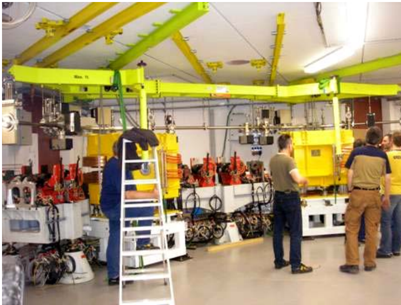
Рис.39. Монтаж накопительного кольца MLS.
