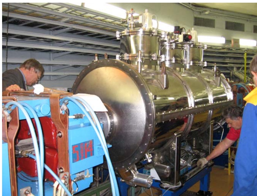
Рис. 36. Монтаж 21-полюсного сверхпроводящего вигглера с полем 7.7 Тесла и периодом 164 мм на накопителе «Сибирь-2» (РНИЦ «Курчатовский институт», Москва).
