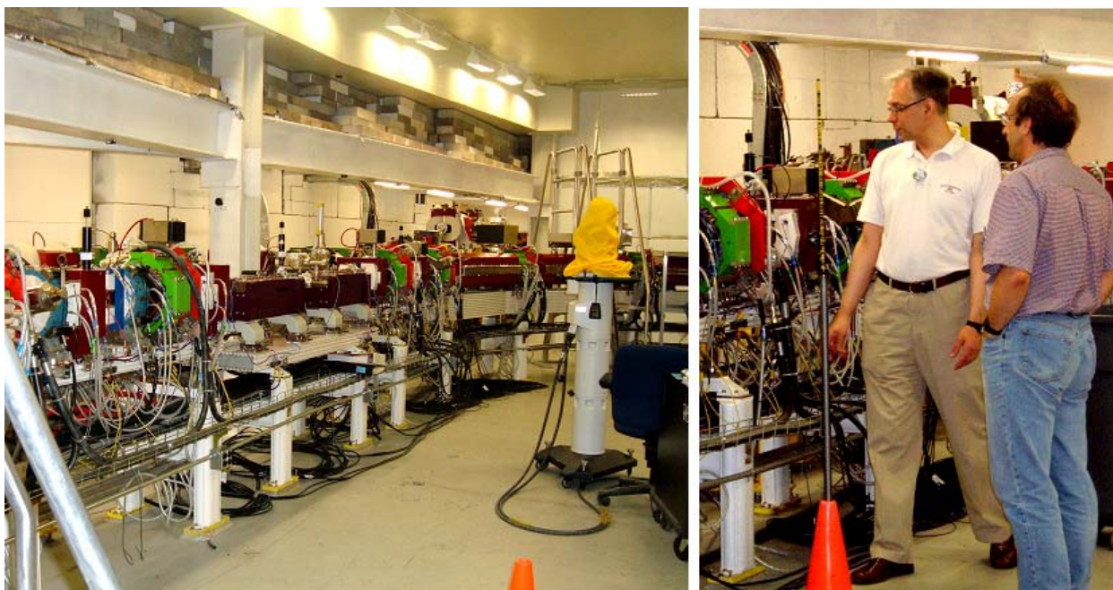
Рис. 38. Процесс монтажа синхротрона-инжектора для Duke University.
